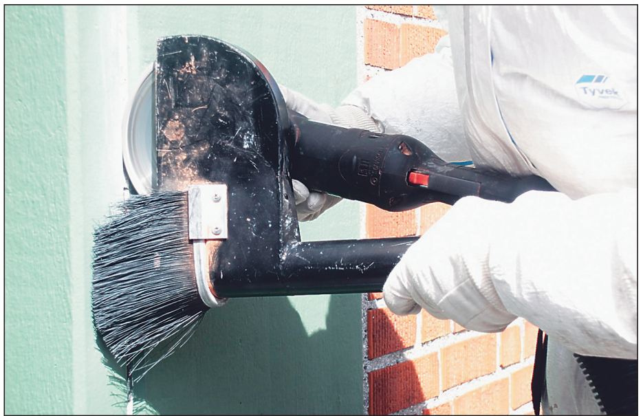
Fog skärs ut med diamantkapskiva.
